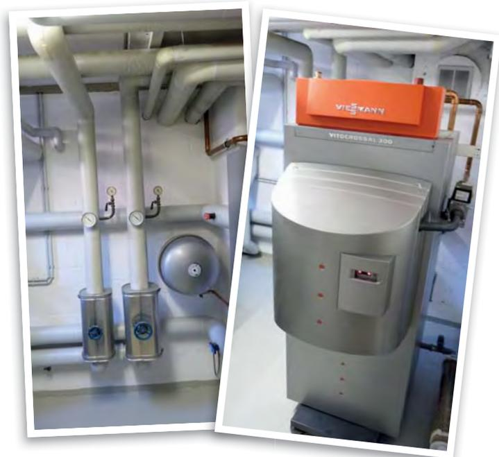
Im Zentrum der Anlage arbeitet ein hochmoderner Systemspeicher. Dieser speichert die von den Sonnenkollektoren auf dem Dach erzeugte Heizwärme. Ergänzt wird die Anlage durch eine Nachheizung, die mit einem modernen Heizkessel immer dann in die Bresche springt, wenn die Sonnenenergie alleine nicht ausreicht, um für genügend warmes Wasser zu sorgen.
